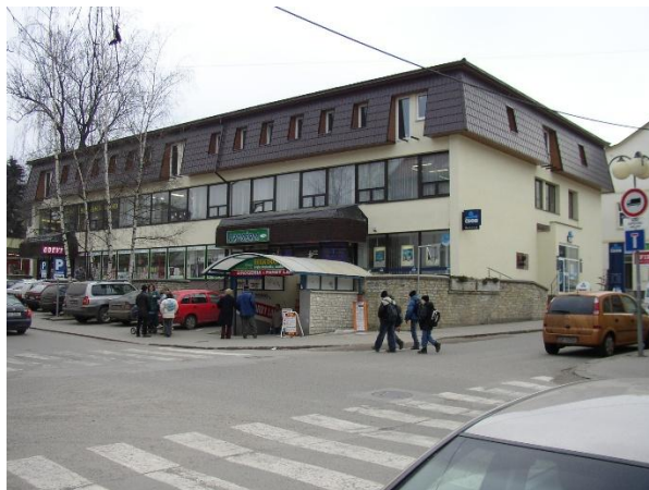
Obr. 34 Nadstavba PO Dolný Kubín.
