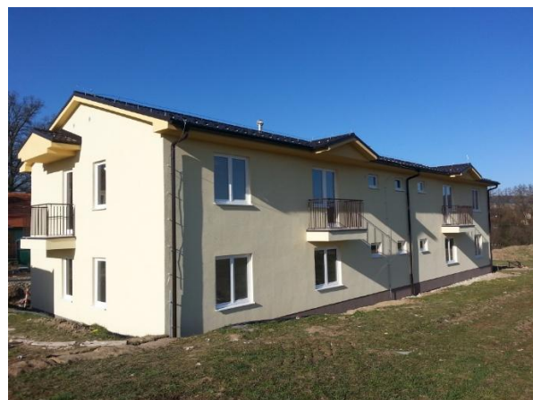
Obr. 30 Bytový dom Kosorín.
