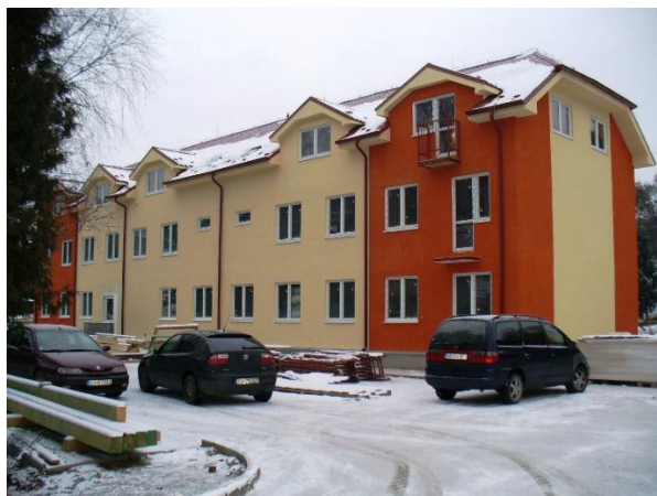
Obr. 28 Bytový dom Banská Belá.
