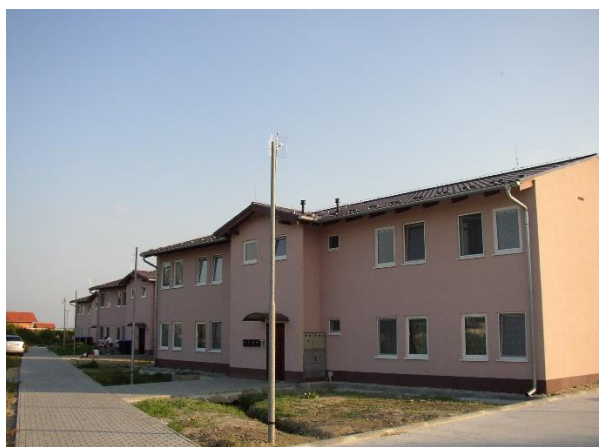
Obr. 31 Bytový dom Kosorín.
